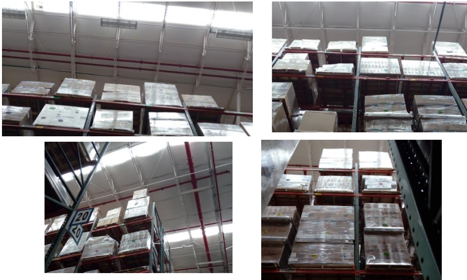
Ilustración 18 Material sobrepasa las medidas según requerimiento de FM Global
